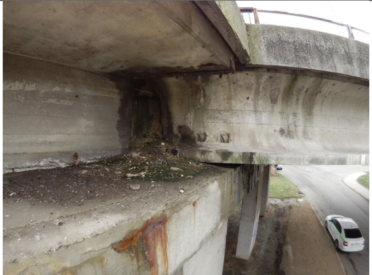
Obr. 5: Pohled na vrchní část úložného prahu a na konce předpjatých nosníků
