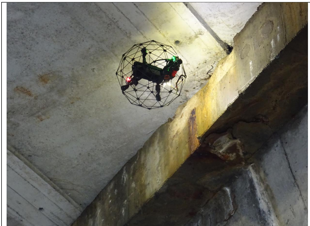
Obr. 2: Dron při průzkumu mostu
