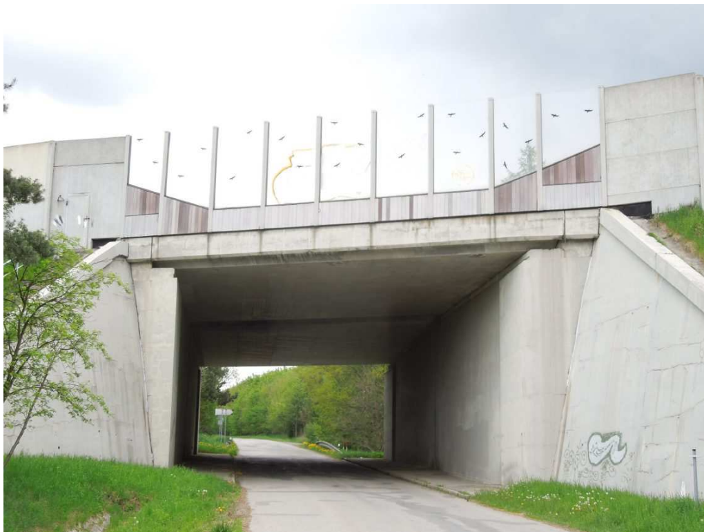
Obr. 1 Pohled na most z pravé strany ve směru staničení
