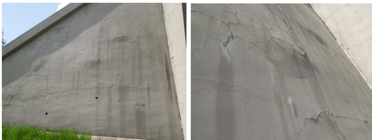
Obr. 4 Pohled na křídlo opěry a detail
