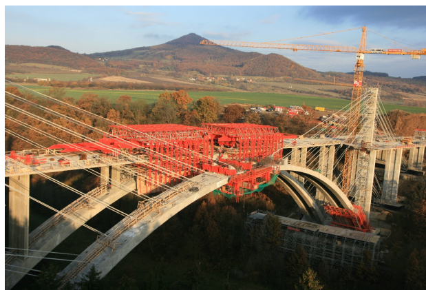
Obr. 1 Výstavba oblouku mostu letmou betonáží
