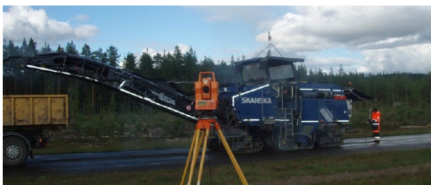
Obr. 1 Frézovací práce dálkově řízené totální stanicí [1].
