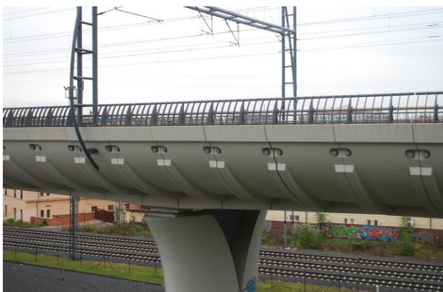
Obr. 1. Pohled na mostní konstrukci.
