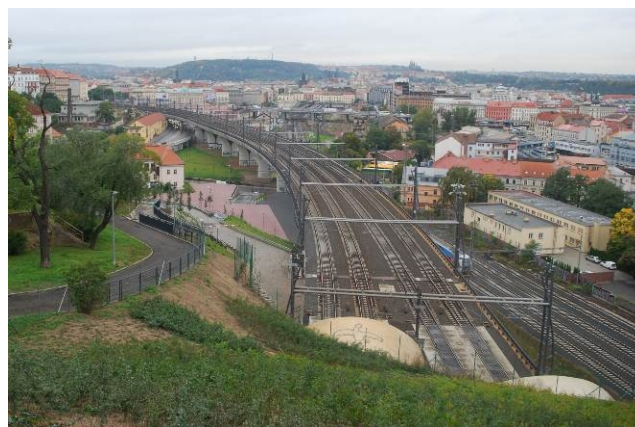
Obr. 3. Pohled na estakádu od Vítkovské opěry.
