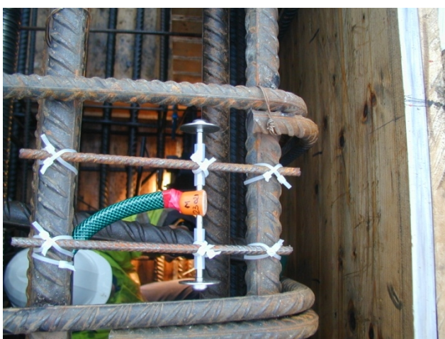
Obr. 3 Uložení tenzometrů v armokoši oblouku mostu.
