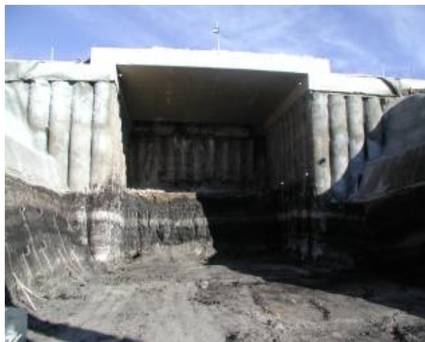
Obr.1 Vjezdový portál železničního tunelu Březno, který bylo nutné během výstavby stabilizovat tuhou betonovou konstrukcí.
