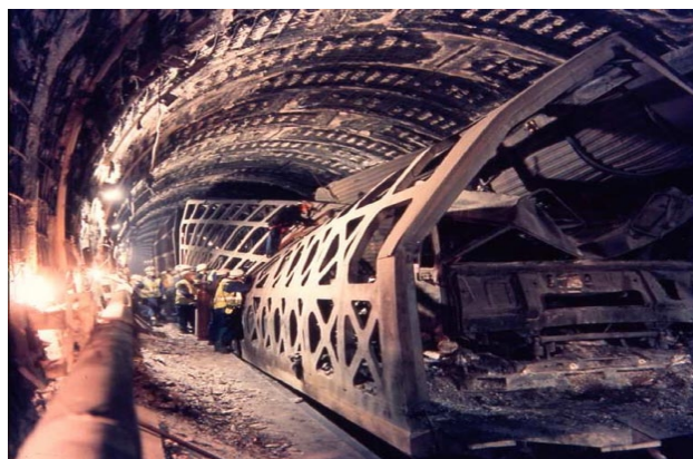
Obr. 1 Snímek následků požáru vlakové soupravy v Channel Tunnel [1, 2, 3].
