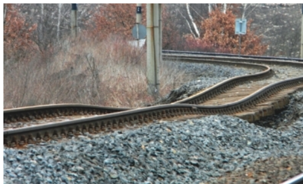
Obr. 1 Sesuv náspu na trati Chomutov – Cheb.
