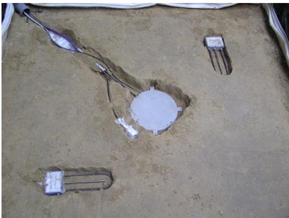
Obr. 2 Uložení snímačů ve výškové úrovni 50 cm.
