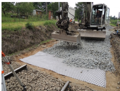
Obr. 2 Vložení geokompozitu pod kolejové lože.
