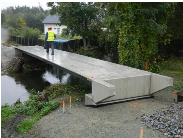
Obr. 3 Pohled na hotovou lávku pro pěší z UHPC přes Opatovický kanál.
