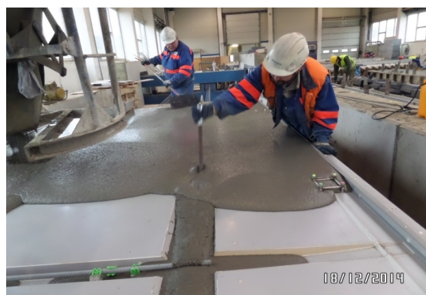
Obr. 2 Postup ukládání čerstvého UHPC do formy.
