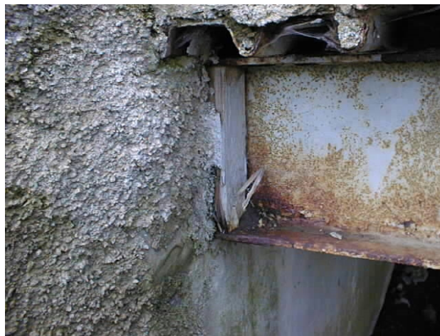
Obr. 1 Nemožnost podélné dilatace a pootáčení.
