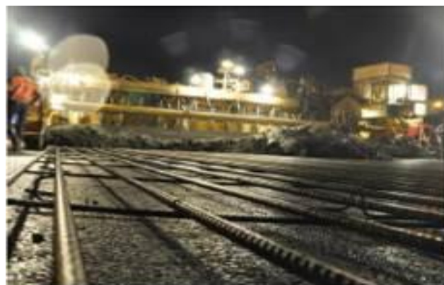
Obr. 4 Instalace podélné výztuže a betonáž úseku na A2 ve směru Berlín, Polsko.
