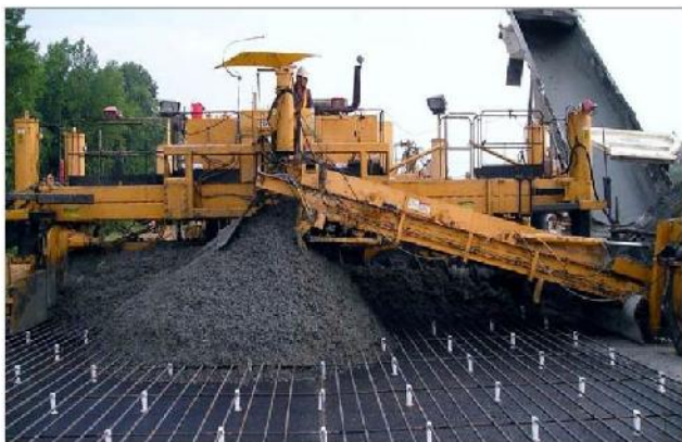
Obr. 1 Příklad použití CRCP na dálnici ve Virginii, USA.
