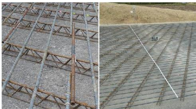
Obr. 3 Instalace tenzometru na podélné výztuži.
