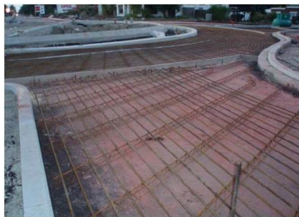
Obr. 2 Příklad použití CRCP na okružní křižovatce.
