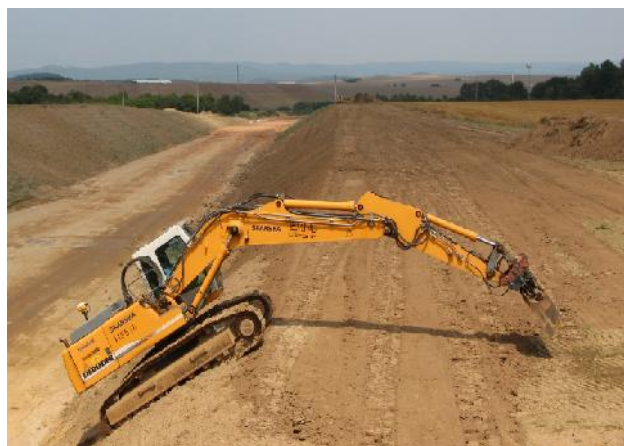
Obr. 4 řízení / navádění stavebního stroje na stavbu D4 Skalka - křižovatka II/118.
