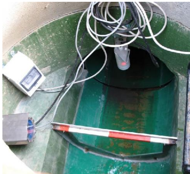
Obr. 2 Za ízení používané p í m ení pr toku vody v šacht .
