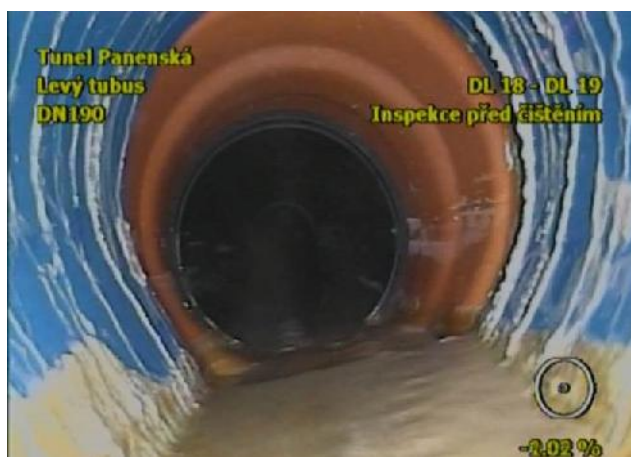
Obr. 3 P íklad kamerové prohlídky – oblast napojení dvou segment .
