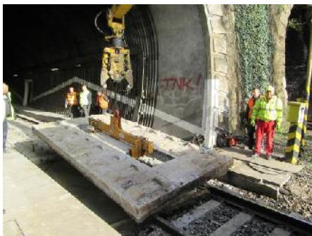
Obr. 2 Bourání poškozené PJD.
