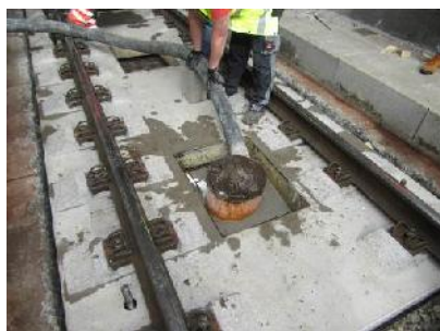
Obr. 4 Betonáž nové PJD.
