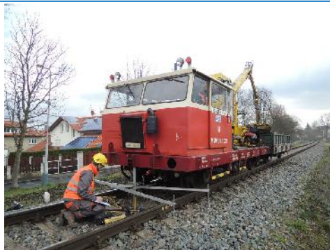
Obr. 2 Statická zatěžovací zkouška v ose koleje.
