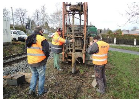
Obr. 1 Provád ní jádrového vrtu podél zkušebního úseku.
