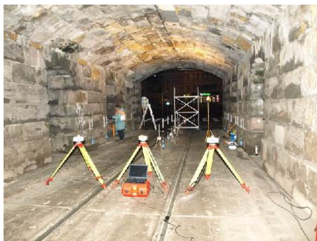
Obr. 3 Měření deformací odezvy klenbového mostu.
