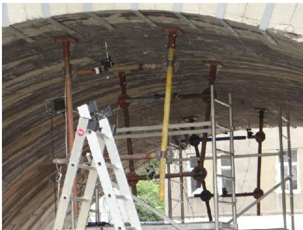
Obr. 1 Soustava ramenátových zesilovačů in situ.
