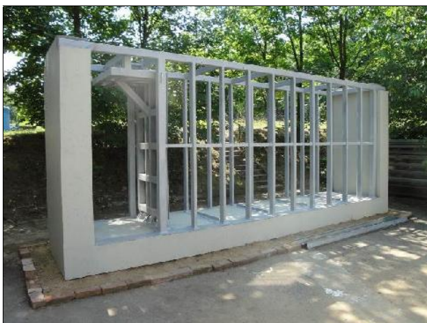
Obr. 1 Základní část zkušebního zařízení krátce před dokončením.
