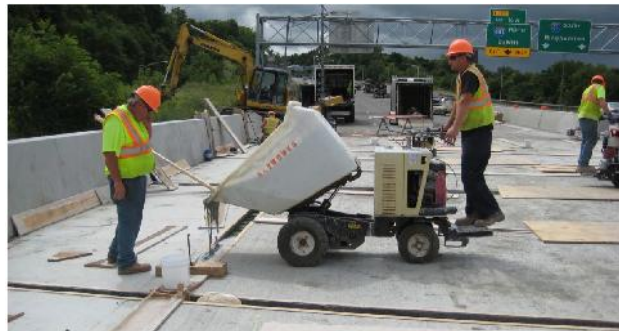
Obr. 4 Ukázka betonáže spojů prefabrikované desky.
