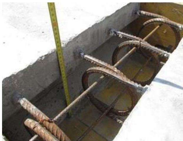
Obr. 2 Petlicový styk výztuže ve spoji.
