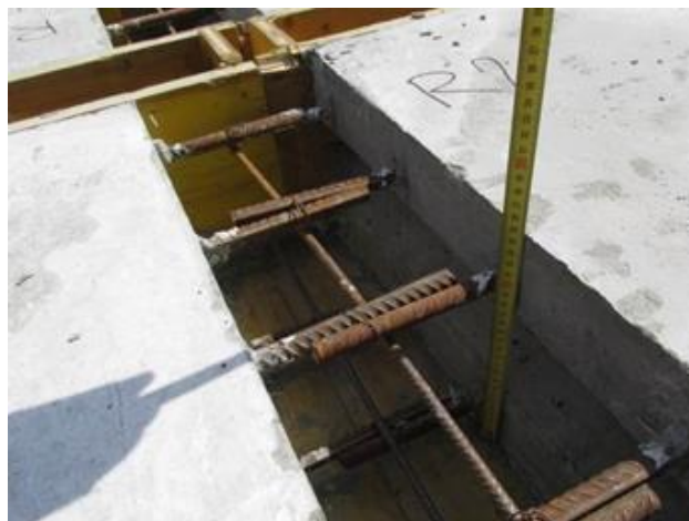
Obr. 1 Prostý přesah výztuže ve spoji.
