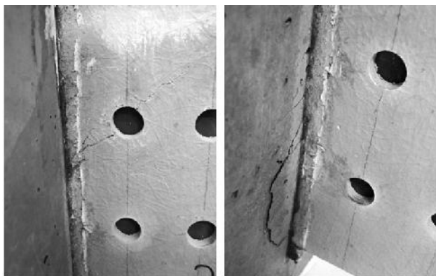
Obr. 3 Poškození vzork : trhliny v FRP, trhliny v HPC.
