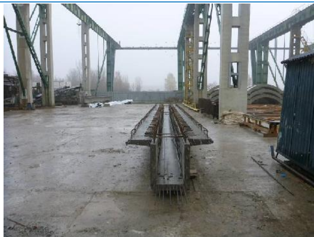
Obr. 6 Pr hled nosníkem.
