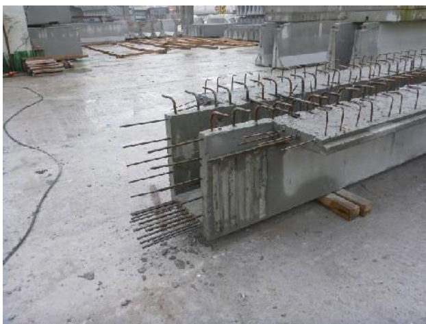
Obr. 5 Pohled na konec nosníku s profilací.
