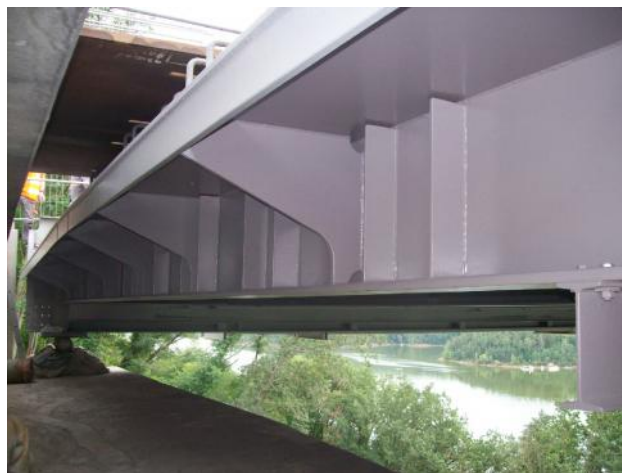
Obr. 2 Koncový p í ník po rekonstrukci.
