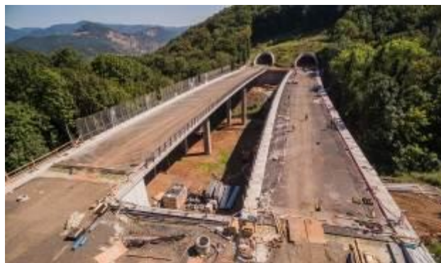
Obr. 2 Celkový pohled na most F211 na D8.
