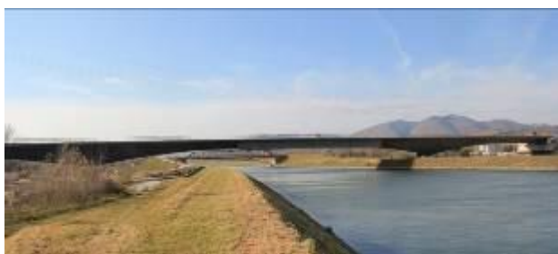
Obr. 1 Celkový pohled na most přes Biskupický kanál a Váh v Trenčíně.
