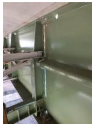
Obr. 3 Vystrojení kompletního řezu mostu tenzometry (deska / horní pásnice / dolní pásnice).
