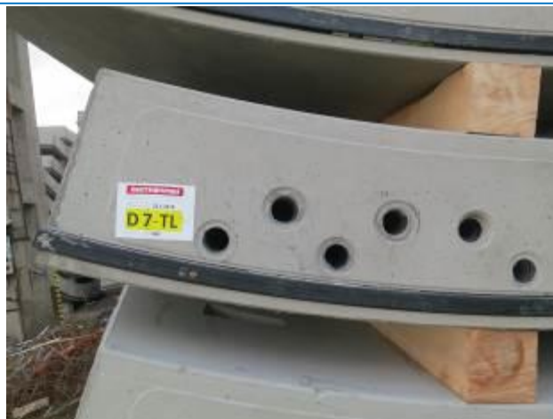
Obr. 3 Otvory pro trny ve vyrobeném segmentu.
