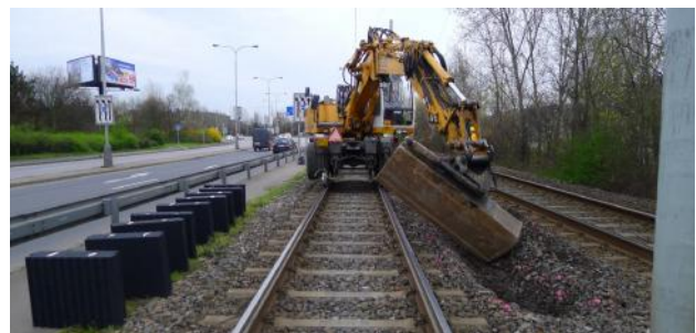
Obr. 1 Hloubení rýhy pro MPC pomocí dvoucestného bagru.
