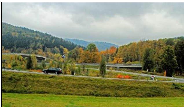
Obr. 1 Dokumentace stavby dopravní infrastruktury a krajiny.
