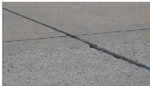
Obr. 1 Údržba povrchu CB krytů technologií jemného frézování – neupravený/upravený povrch.
