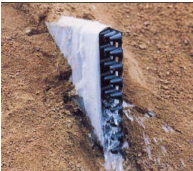
Obr. 2 Příklad aplikace prefabrikované geokompozitní drenáže - detail
