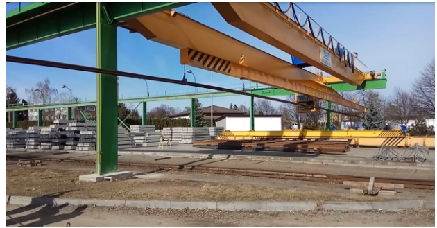
Obr. 1 Manipulace s kolejnicí pomocí trámce
