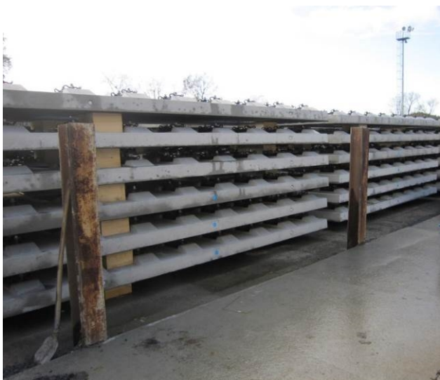
Obr. 4 Panely konstrukce pevné jízdní dráhy OBB-PORR na mezideponii
