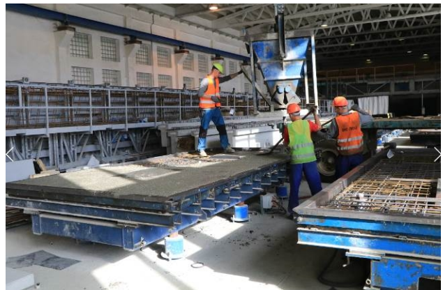
Obr. 2 Betonáž panelů konstrukce pevné jízdní dráhy OBB-PORR
