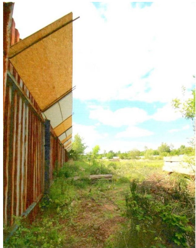
Obr. 1 Stěna s integrátorem – detail.
