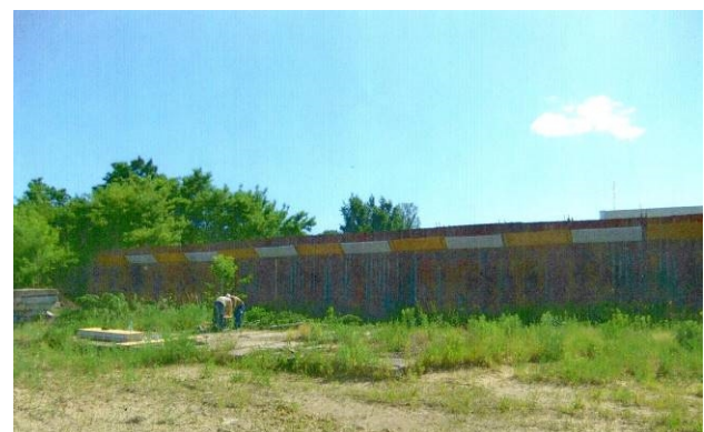
Obr. 2 Stěna s integrátorem – celkový pohled.
