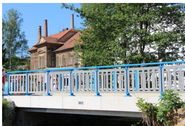
Obr. 3 Most ev. .SZ-001 v m st Sázava po rekonstrukci
