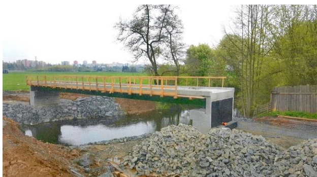
Obr. 5 Provádění monolitických říms.
