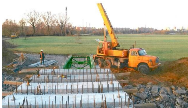
Obr. 2 Osazování panelů.
