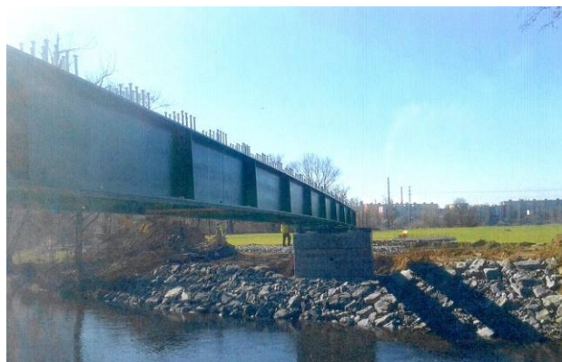
Obr. 1 Ocelové nosníky s hnízdy spávaných trnů.
