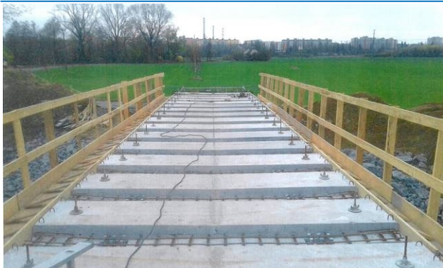
Obr. 4 Celkový pohled na vyarmované pracovní spáry.
