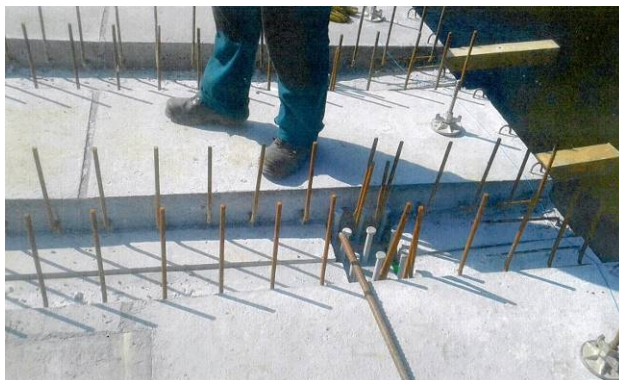
Obr. 3 Armatura kapsy pracovní spáry.
