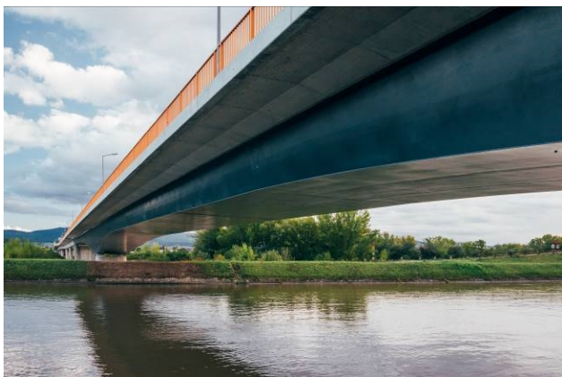
Obr. 1 Pohled na hlavní pole mostu přes Biskupický kanál a Váh v Treníně.
