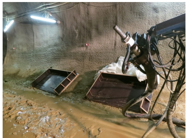
Obr. 1 Formy p ípravené k vyst íkání
