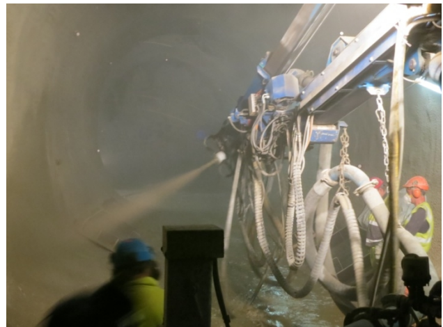
Obr. 2 St íkání drátkobetonu do forem
