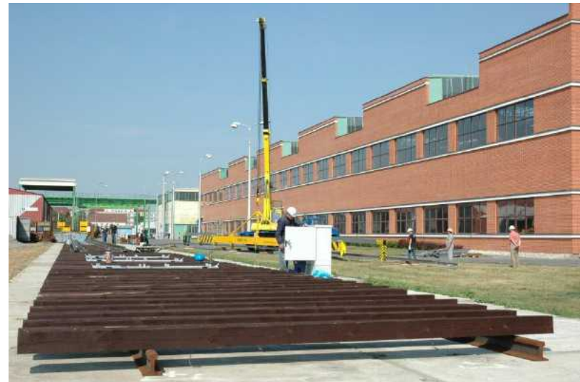
Montáž srdcovkové části
