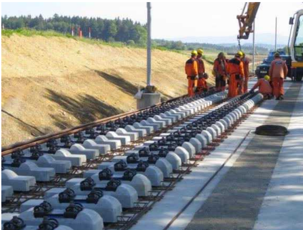
Pokládka dvoublokových pražců, osazení výztuže a betonáž PJD typu RHEDA 2000
