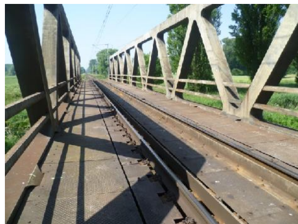
Železniční svršek mostní konstrukce
