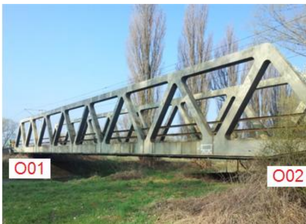
Pohled na mostní konstrukci
