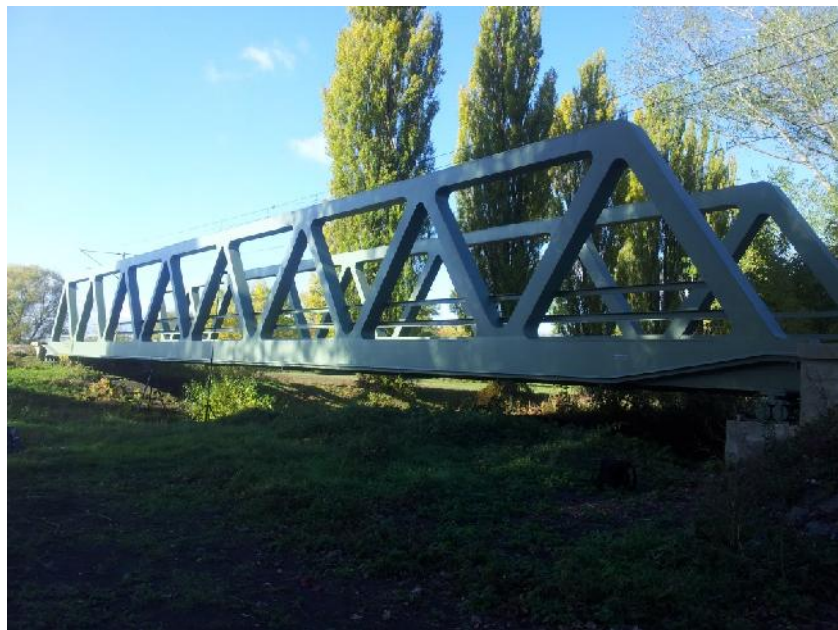
Pohled na mostní konstrukci
