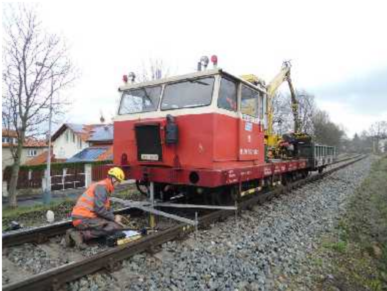
Statické zat žovací zkoušky v úrovni LPP
